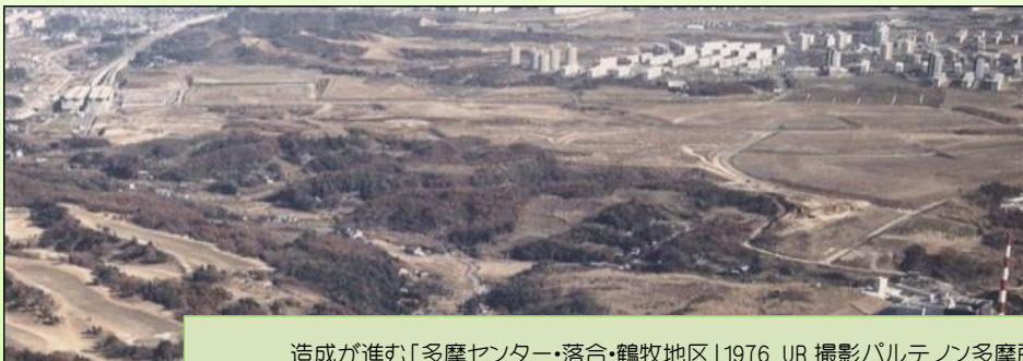
造成が進む「多摩センター・落合・鶴牧地区」1976 UR 撮影パルテノン多摩所蔵
